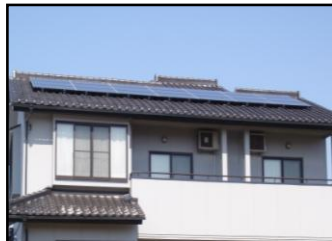
▲太陽光発電システム設置完了
