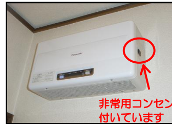
▲太陽光発電システムのパワコン設置
