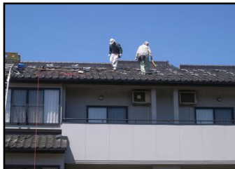
▲太陽光発電システム設置工事の様子
